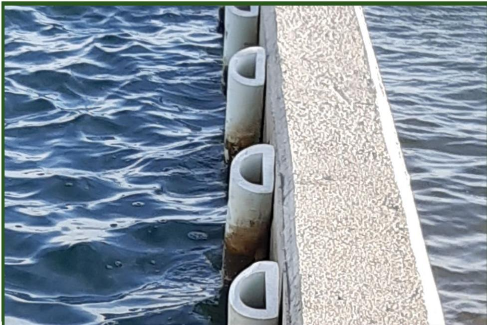
DEFENSAS marinas fabricadas en etylenpropilene Rubber (caucho EPDM), ideal para las condiciones marinas, resistente al ozono e inmune al envejecimiento prematura. Las defensas de goma negra se suelen instalar en puertos de pesca, puertos comerciales, etc.
